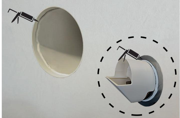
5. Ausseneinsatz in das Rohr einsetzen bei verkanten Tropfblech etwas nach innen drücken. (→)
