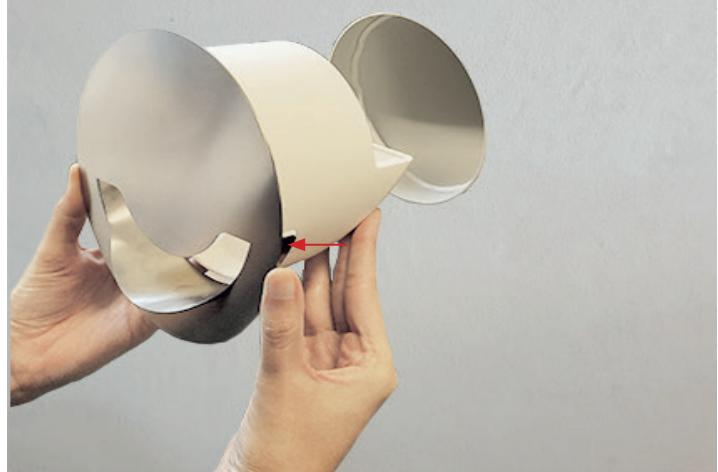
6. Ausseneinsatz fassadenbündig einschieben und mit Wasserwaage ausrichten.
