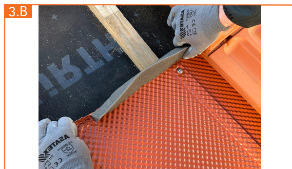
3.B Äußere Ende der Pfanne einklappen und Umlegefalz mit aufgeklebtem Kehldichtstreifen aufklappen
