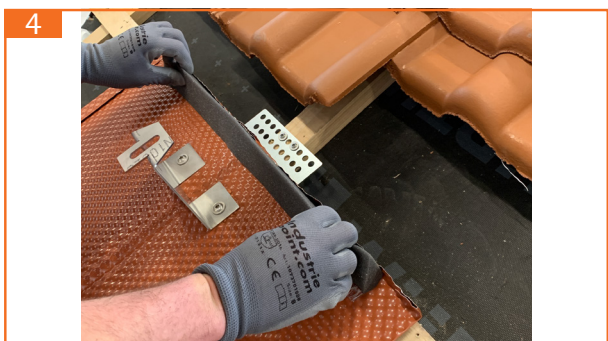
4. Schutzfolie des Kehldichtstreifens (500 mm) ab- ziehen und Kehldichtstreifen bündig zur Oberkante anbringen.
