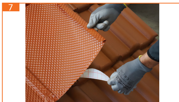
7. Schutzfolie des Butylklebestreifens abziehen.
