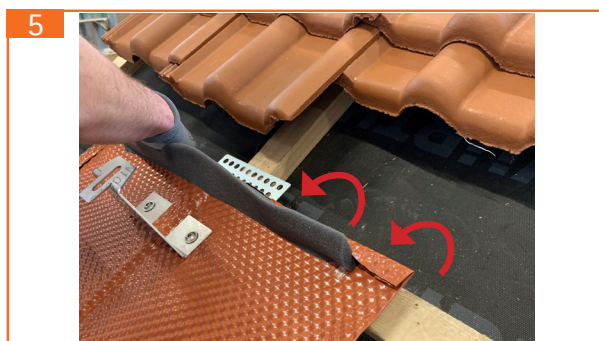
5. Obere Aluminiumkante einschlagen.
