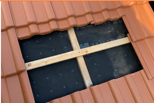
2. Dachziegel/Dachstein entnehmen
