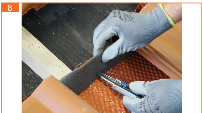
8. Kehldichtstreifen an Dachhakenposition L-förmig einschneiden.
