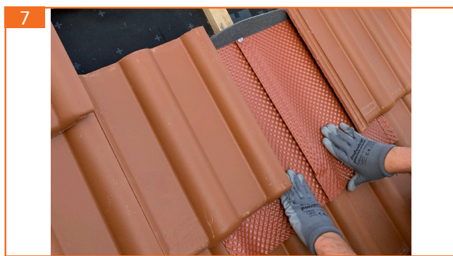
7. geba PV flex an Kontur des Ziegels mittig beginnend nach außen anformen und fest andrücken
