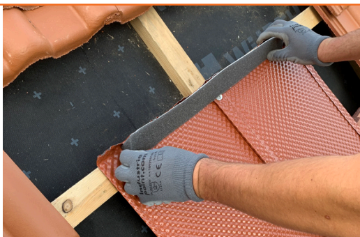
3.A Kehldichtstreifen vor den Umlegefalz kleben
