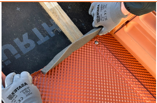
3.B Äußere Ende der Pfanne einklappen und Umlegefalz mit aufgeklebtem Kehldichtstreifen aufklappen
