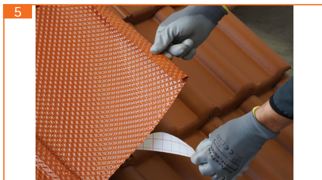
5. Schutzfolie des Butylklebestreifens abziehen
