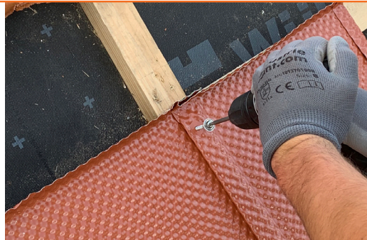
3. PV-flex mit Spenglerdichtschraube (4 x 30 mm, TX 20) fixieren) - bei Bedarf -
