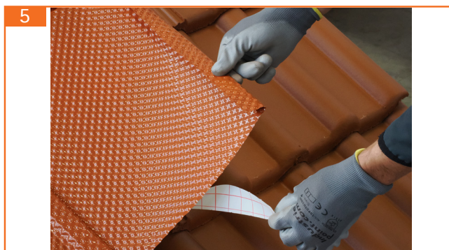
5. Schutzfolie des Butylklebestreifens abziehen
