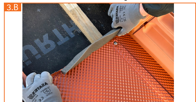
4.B Äußere Ende der Pfanne einklappen und Umlegefalz mit aufgeklebtem Kehldichtstrieifen aufklappen
