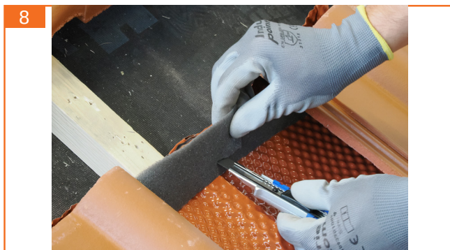
8. Kehldichtstreifen an Dachhakenposition L-förmig einschneiden.
