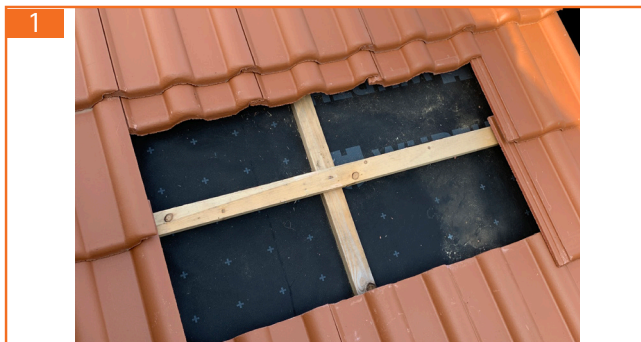
2. Dachziegel/Dachstein entnehmen
