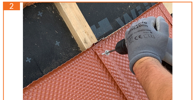
3. PV-flex mit Spenglerdichtschaube (4 x 30 mm, TX 20) fixieren) - bei Bedarf -
