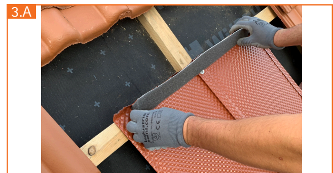
3.A Kehldichtstreifen vor den Umlegefalz kleben
