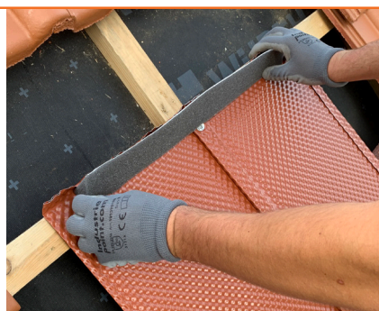
5.A Kehldichtstreifen vor den Umlegefalz kleben
