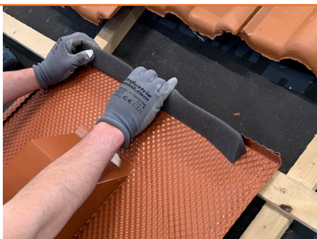
6. Schutzfolie des Kehldichtstreifens (500 mm) abziehen und auf der oberen Kante anbringen.
