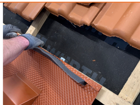
7. Obere Aluminiumkante einschlagen
