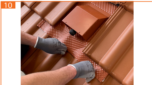
10. geba KD-PV an Kontur des Ziegels mittig beginnend nach außen anformen und fest andrücken.
