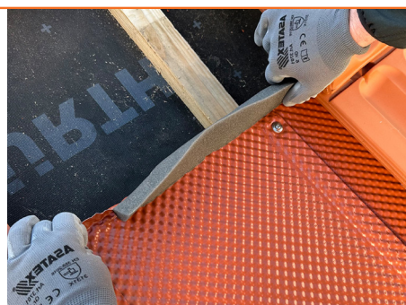
5.B Äußere Ende der Pfanne einklappen und Umlegefalz mit aufgeklebtem Kehldichtstrieifen aufklappen
