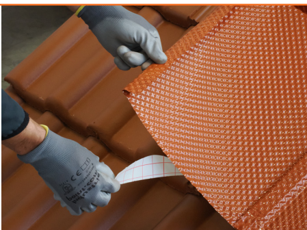
8. Schutzfolie des Butylklebestreifens abziehen.
