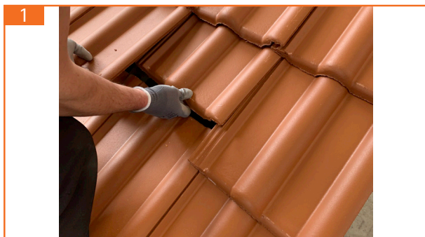
1. Öffnung herstellen, Dachziegel entfernen
