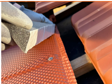
5.B Umlegefalz nach hinten biegen, Kehldichtstreifen auf Umlegefalz kleben
