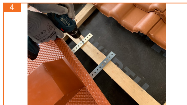
4. geba SDL-PV ausrichten und mit Dachlatte verschrauben
