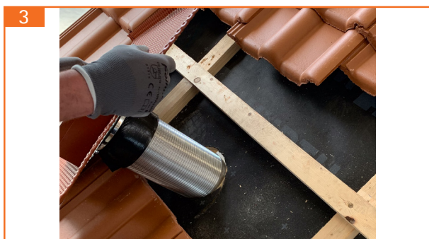
3. Lüftungsrohr der geba SDL-PV einsetzen
