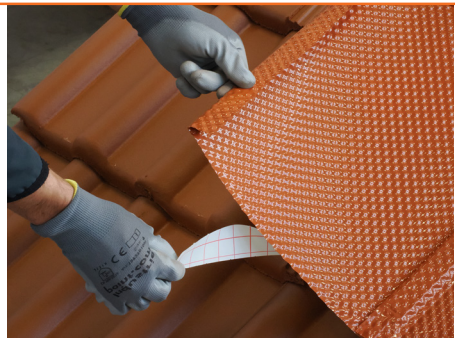
6. Schutzfolie des Butylklebestreifens abziehen.
