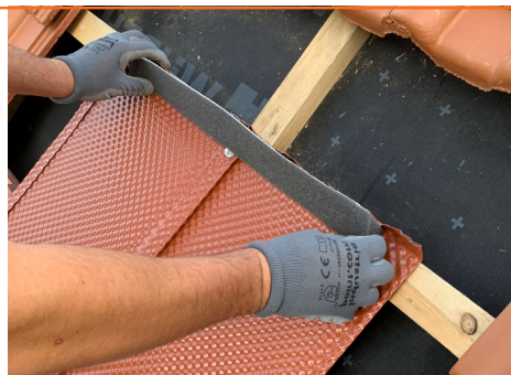
5.A Kehldichtstreifen vor den Umlegefalz kleben
