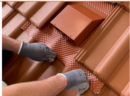
8. geba SDL-PV an Kontur des Ziegels mittig beginnend nach außen anformen und fest andrücken.
