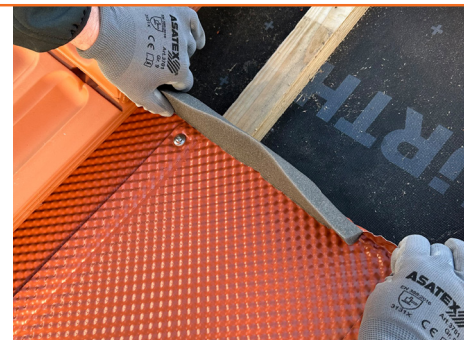
5.B Äußere Ende der Pfanne einklappen und Umlegefalz mit aufgeklebtem Kehldichtstriefen aufklappen
